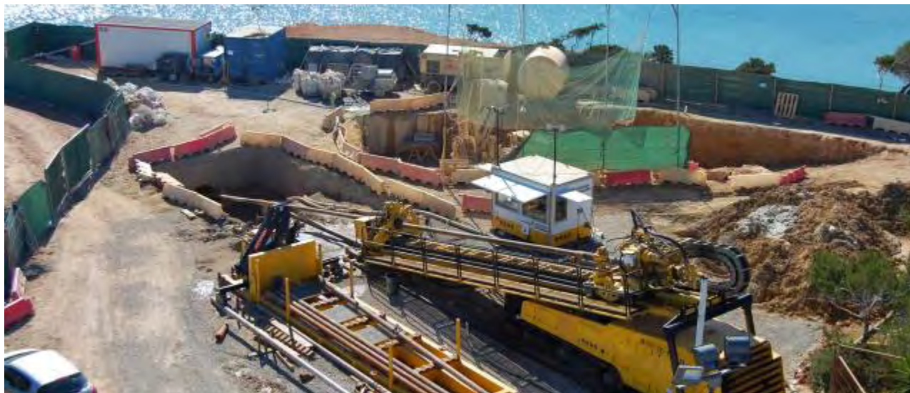
Figura 32. Maquinaria y equipamiento para la perforación horizontal dirigida. / Tomado de i.Agua.
