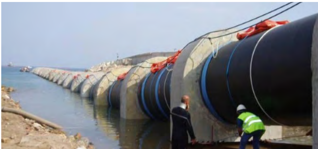
Figura 35. Tuberías de polietileno para instalaciones submarinas lastradas. / Tomado de iAgua.
