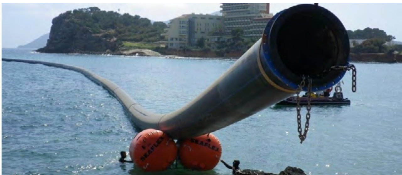
Figura 31. Instalación de tuberías para conducir el agua. / Tomado de iAgua.
