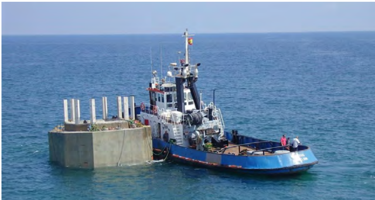
Figura 29. Cajón de toma flotando durante el remolque. / Tomado de iAgua.
