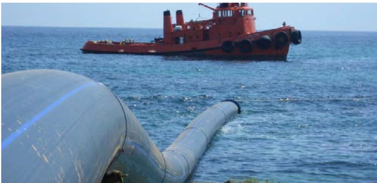
Figura 26. Introducción de la tubería de la toma en el mar. / Tomado de iAgua.
