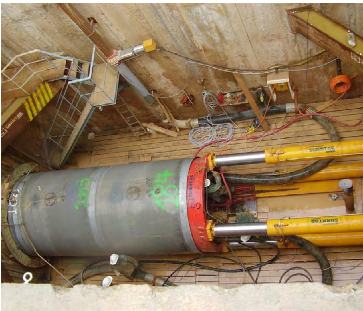
Figura 6. Obras de excavación de un sistema de captación cerrada. / Tomado de iAgua.
