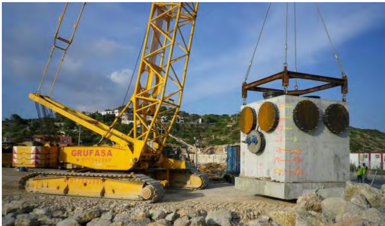
Figura 28. Construcción y traslado de cajón de toma de hormigón. / Tomado de iAgua.
