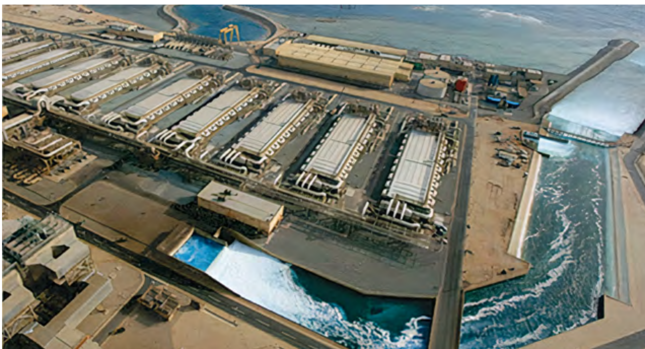
Figura 13. Planta desalinizadora en Atacama. / Tomado de Structuralia.
