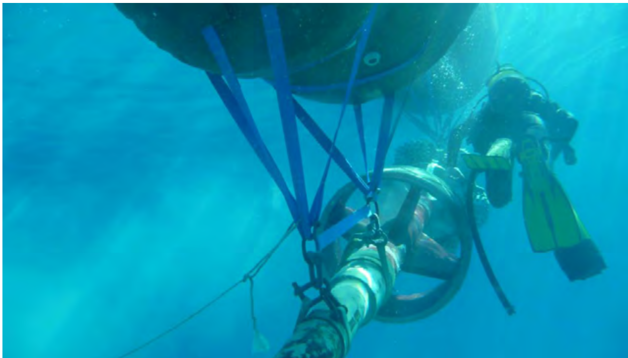
Figura 27. Participación de los buzos en el proceso de instalación de tomas de agua. / Tomado de iAgua.
