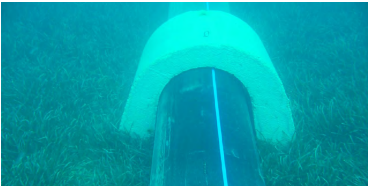
Figura 36. Lastres de hormigón armado para sujetar las tuberías al fondo marino. / Tomado de iAgua.
